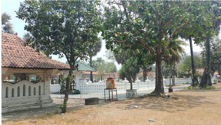
Gambar 2. Lokasi Cepuri Parangkusumo dilihat dari arah tenggara (Sumber: TACB Kabupaten Bantul 2024)
