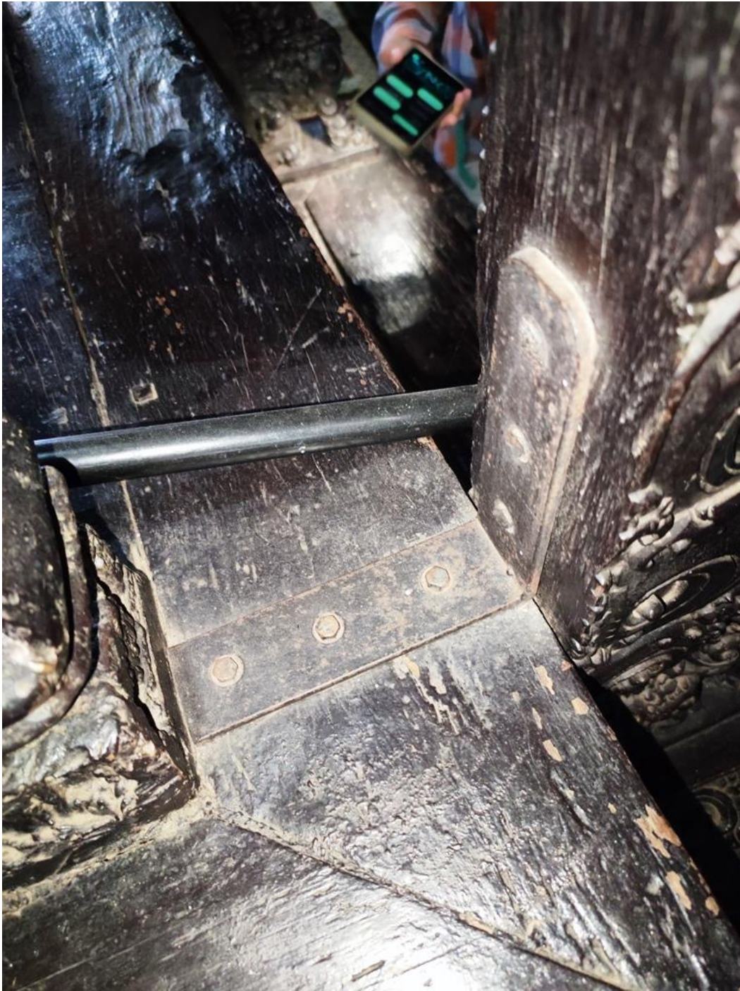
Foto 5. Perkuatan plat besi Mimbar Masjid Gedhe Mataram Kotagede (Sumber: TACB Bantul, 2024)
