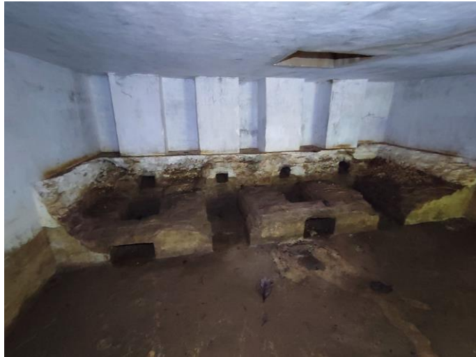
Gambar 7. Sisa tungku-tungku pada ruang sisi selatan Gua Jepang Nomor 16 (Sumber: TACB Kabupaten Bantul, 2024)
