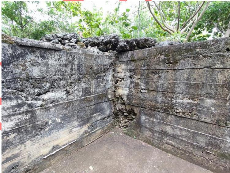
Gambar 5. Sudut barat laut Gua Jepang Nomor 12 yang mengindikasikan bagian langit-langit yang telah runtuh
