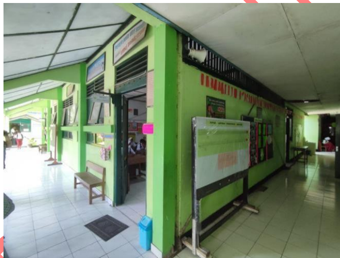
Gambar 5. Bangunan Kelas SD Negeri Wojo I dilihat dari sisi timur laut (Sumber: TACB Bantul 2022)
