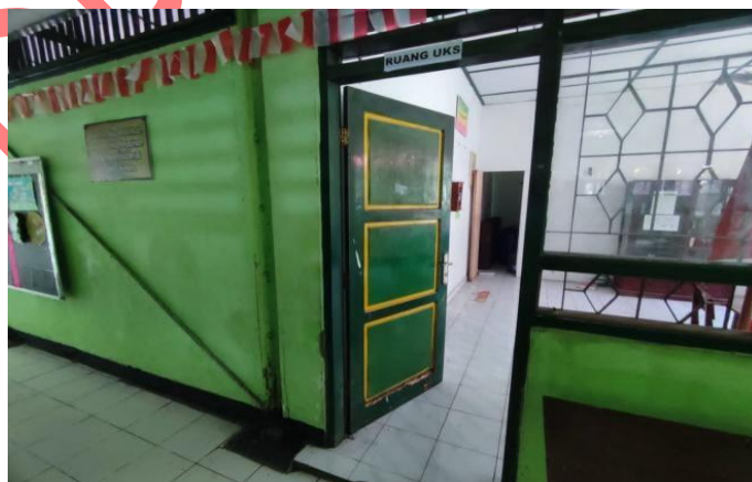
Gambar 6. Bangunan baru yang menempel pada sisi barat bangunan kelas (Sumber: TACB Bantul 2022)
