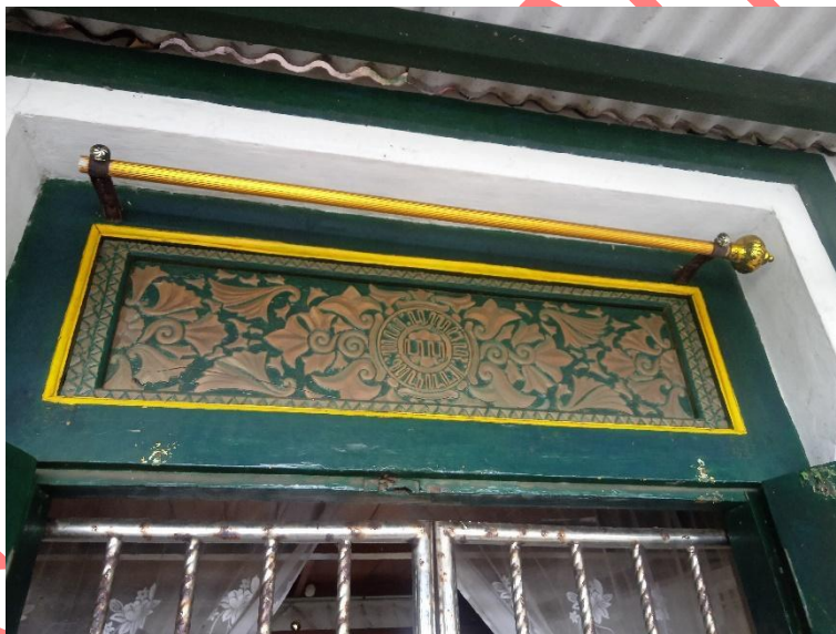
Gambar 1. Inskripsi pada bagian atas pintu Cungkup Makam Syekh Belabelu dan Syekh Damiaking di Padukuhan Mancingan, Kalurahan Parangtritis, Kapanewon Kretek, Kabupaten Bantul (Sumber: TACB Bantul 2023)
