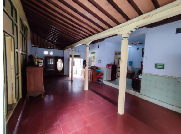
Emper Dalem dari sisi barat daya (Sumber: Tim TACB Bantul, 2022)
