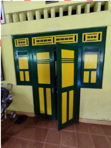
Pintu dan jendela Dalem sebelah barat (Sumber: TACB Bantul 2022)
