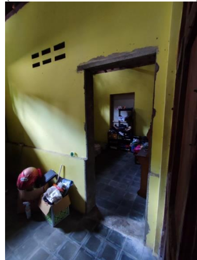
Pintu baru yang dibuat pada dinding barat senthong tengen (Sumber: TACB Bantul 2022)
