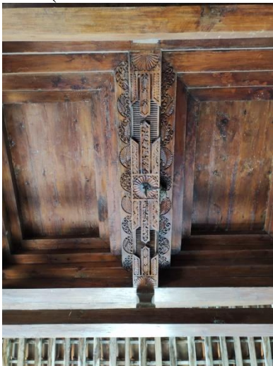
Dhadha peksi pendopo Rumah Tradisional Wiji Yuwono dilihat dari arah barat daya (Sumber: TACB Bantul 2022)
