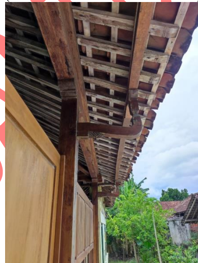
Bahu dhanyang pendopo Rumah Tradisional Wiji Yuwono dilihat dari arah barat daya (Sumber: TACB Bantul 2022)
