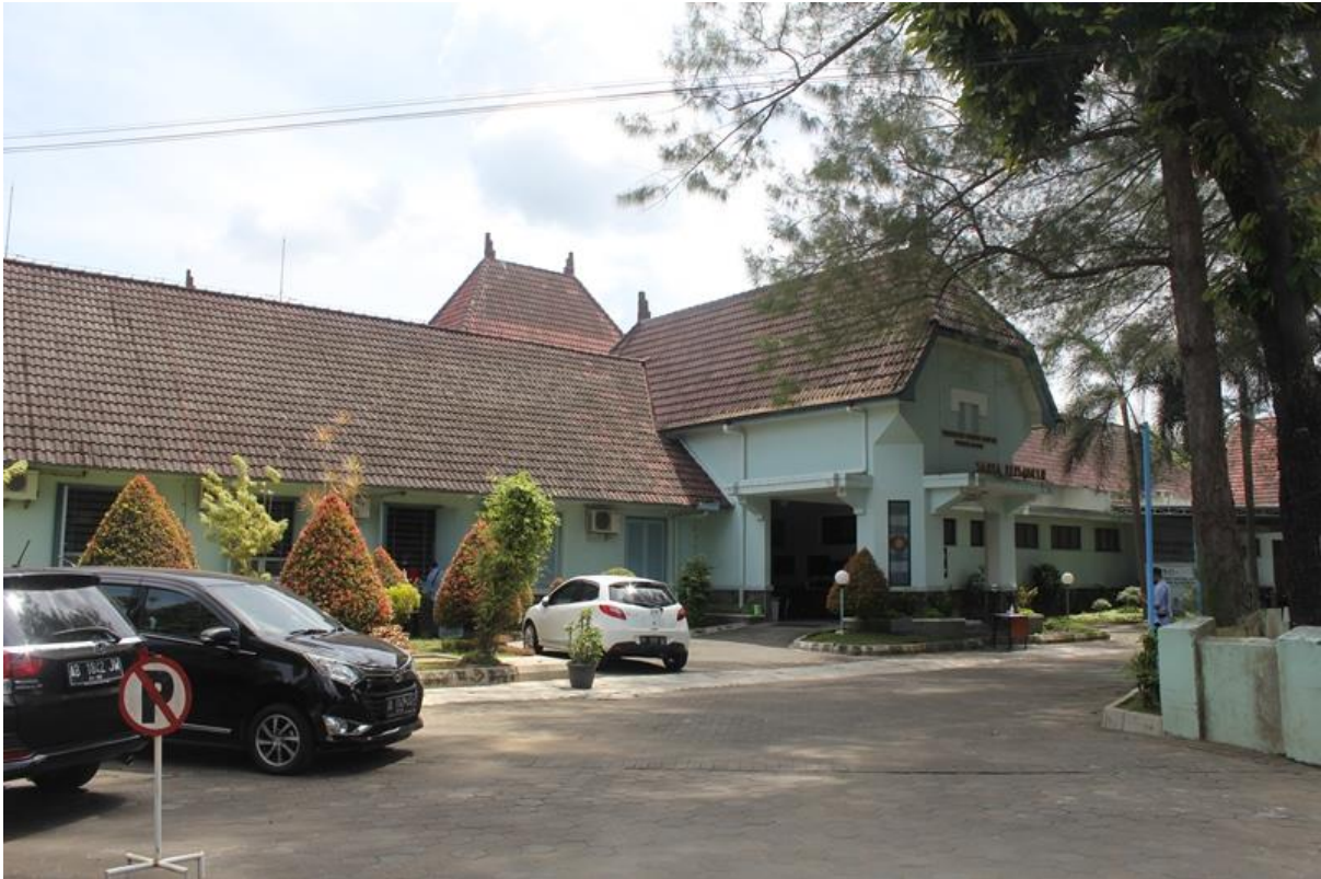
Rumah Sakit Santa Elisabeth Ganjuran di Padukuhan Ganjuran, Kalurahan Sumbermulyo, Kapanewon Bambanglipuro, Kabupaten Bantul (Sumber: TACB Bantul, 2022)
