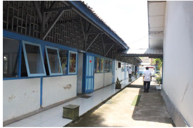
Bangunan SMP Kanisius Bambanglipura dari arah timur laut (Sumber: TACB Bantul, 2022).
