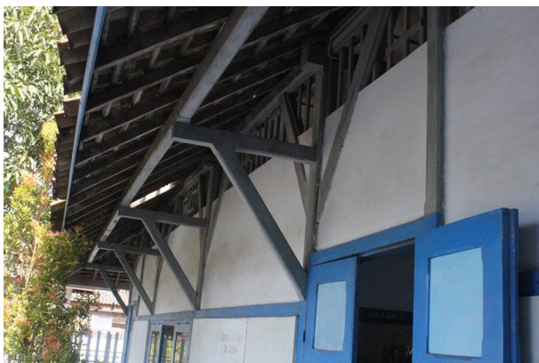
Ram-raman pada dinding selatan bangunan SMP Kanisius Bambanglipura yang ditutup dengan sebagian ditutup dengan tripleks (Sumber: TACB Bantul, 2022)
