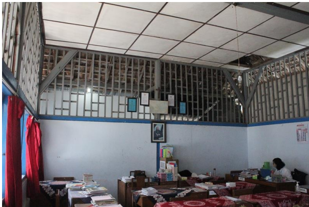
Ram-raman pada bagian atas ruang guru SMP Kanisius Bambanglipura (Sumber: TACB Bantul, 2022)
