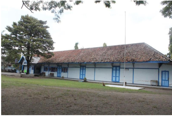
Bangunan SMP Kanisius Bambanglipura dari arah tenggara (Sumber: TACB Bantul, 2022)
