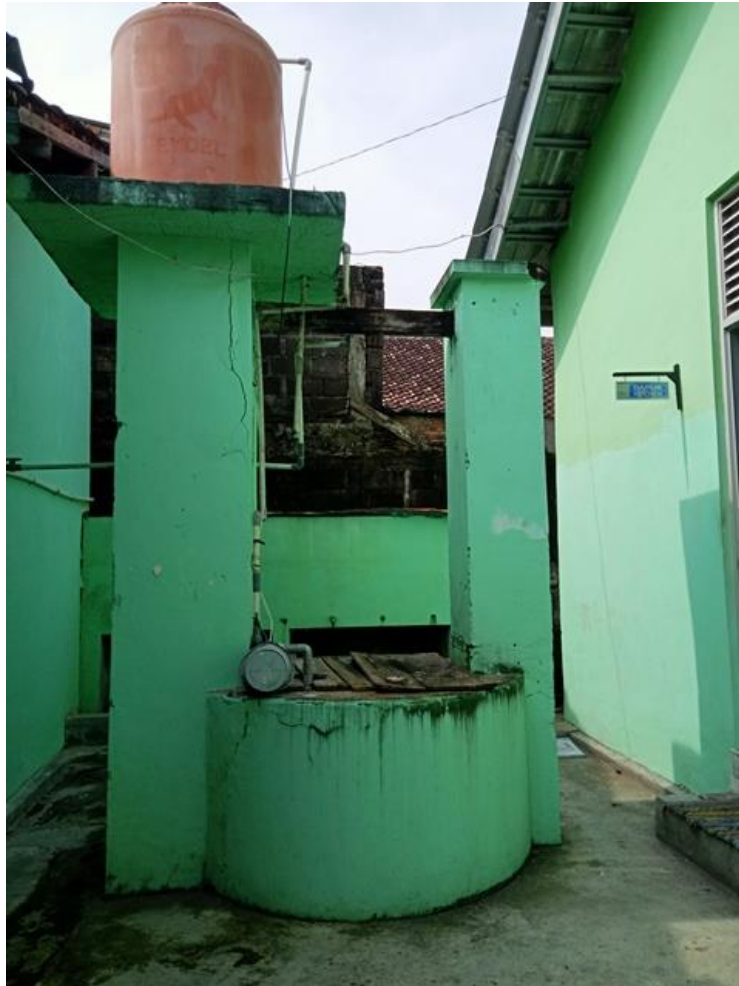
Sumur lama SD Negeri Kasihan dilihat dari sisi utara (Foto: TPCB Bantul 2022)
