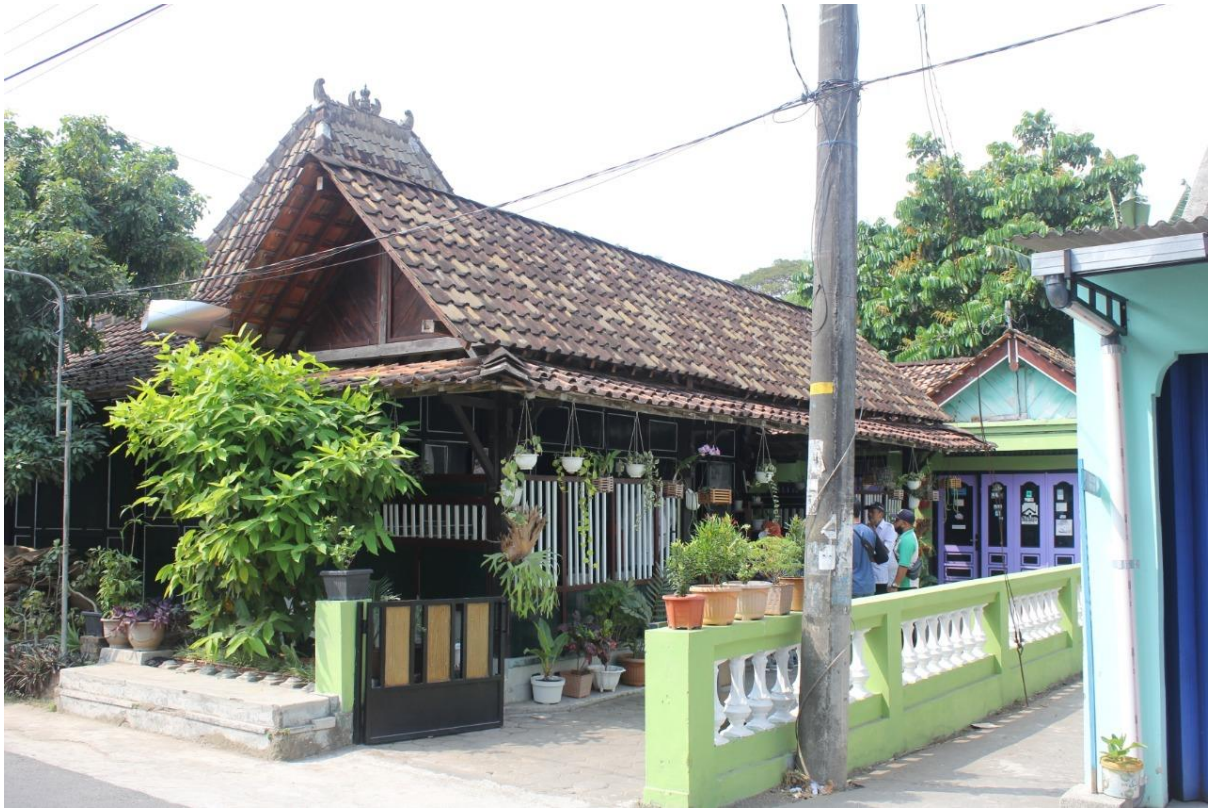
Rumah Tradisional Jawa Eks Kantor Kalurahan Pertama Karangtengah di Padukuhan Karangtengah, Kalurahan Karangtengah, Kapanewon Imogiri, Kabupaten Bantul (Sumber: Tim Ahli Cagar Budaya Kabupaten Bantul, 2021)
