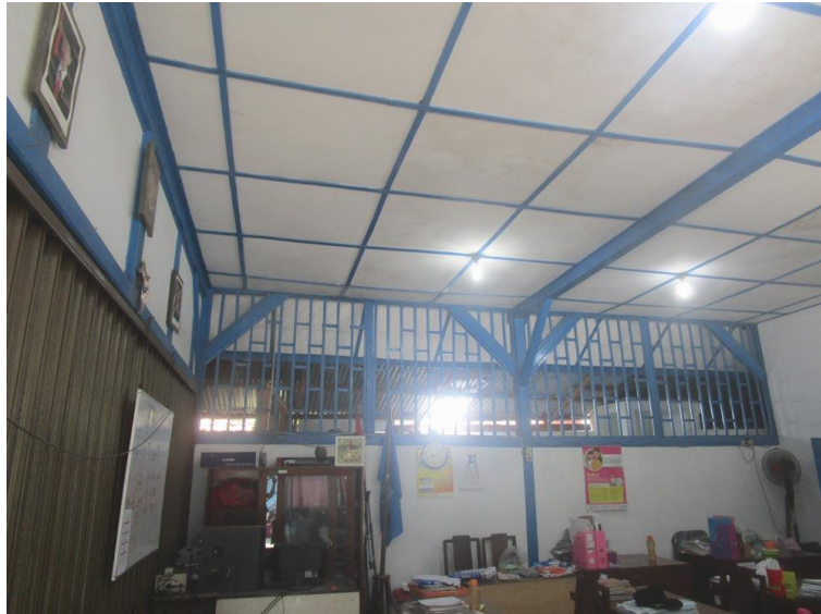
Ruang kelas SD Kanisius Ganjuran dan pintu besi pemisah ruang kelas (Foto: TACB Kab. Bantul, 2019)
