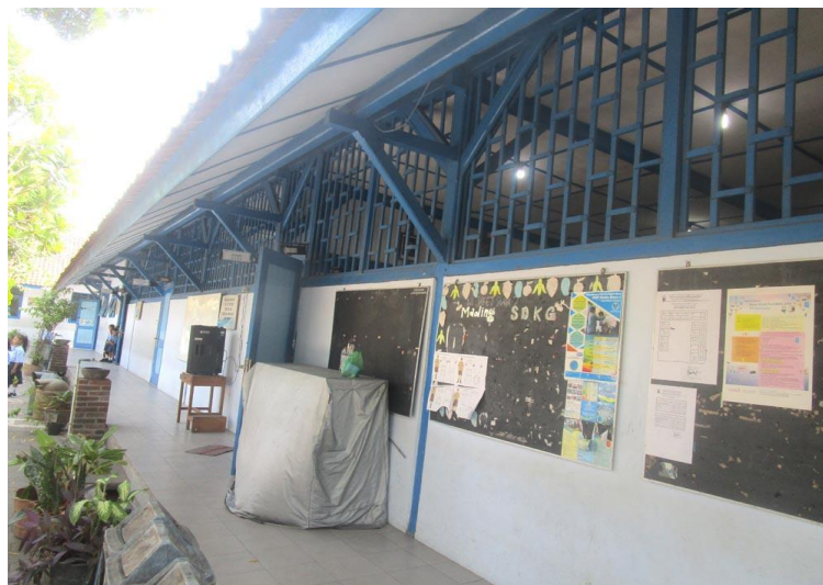
Ram-raman di atas dinding Bangunan SD Kanisius Ganjuran (Foto: TACB Kab. Bantul, 2019)
