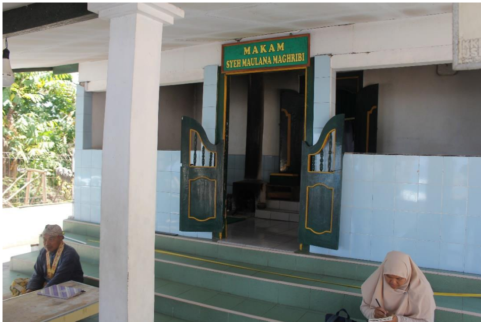
Cungkup Makam Syekh Maulana Maghribi dilihat dari tenggara (Foto: TACB Kab. Bantul, 2019)
