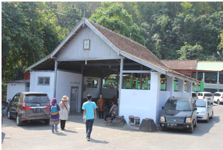
Bale Palereman (Transit) Jenazah Raja-Raja Mataram di Imogiri dilihat dari selatan (Foto: TACB Kab. Bantul, 2019).
