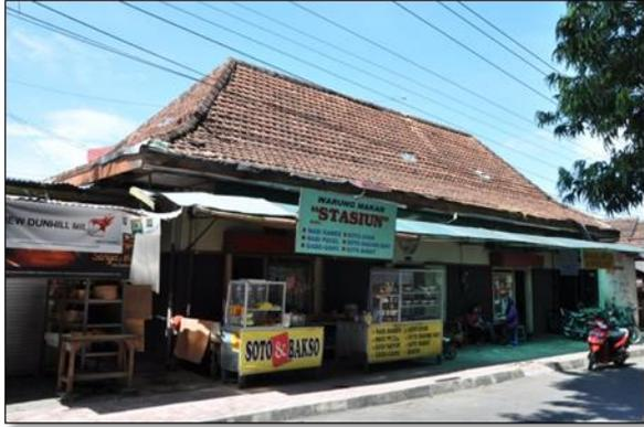
Foto No. D144324. Atap limasan dan tambahan atap fiber di sisi utara
