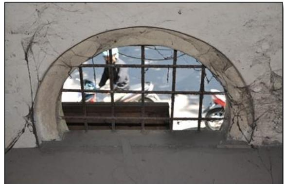
Foto No. D144333. Ventilasi yang sebagian tertutup papan kayu untuk lantai loteng
