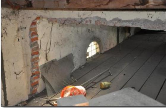
Foto No. D144332. Dinding pembatas yang dibongkar, masih tampak di bagian loteng (foto arsip BPCB DIY, 2012)
