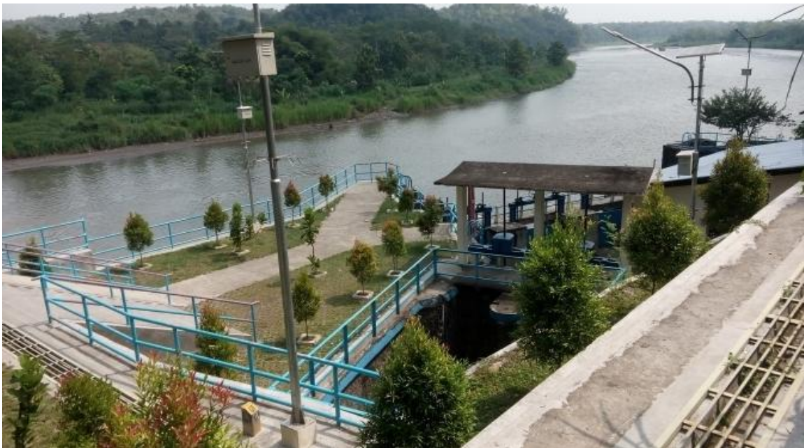
Situasi Dam Kamijoro setelah di Rehab oleh Dinas Kebudayaan dan Pariwisata Bantul tahun 2015, (Foto: Albertus Sartono)
