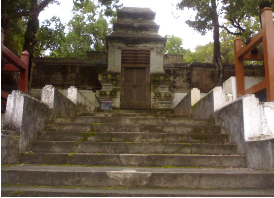
Pintu Gerbang Kompleks Makam Imogiri, Tahun 2014 (Foto: Willy Oktavian)
