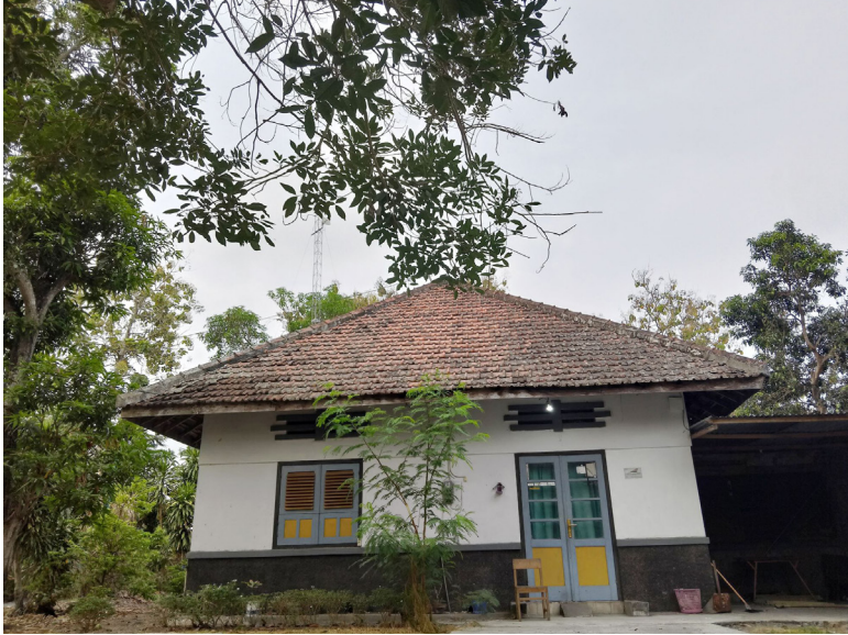
Rumah Pegawai NISM. (Dokumentasi Foto Early Danendra, 2023)
