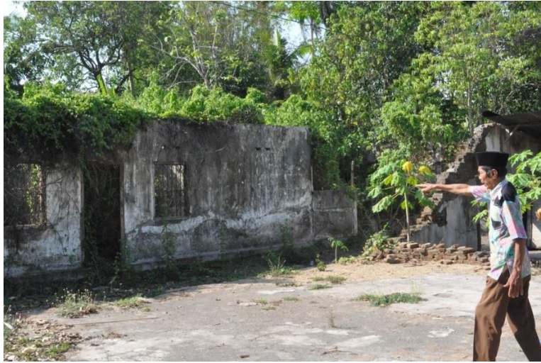
Gambar 3.4. Pak Wardoyo, anak ke-4 Bupati Bantul 1958-1960 Slamet Setyosudarmo saat berdiri di atas puing rumah orang tuanya di Gedangan Pundong Bantul yang rata dengan tanah akibat Gempa Mei 2006. Beliau sedang menunjuk ruang kamar untuk anak-anak Slamet Setyosudarmo, termasuk kamar pak Wardoyo waktu kecil. Rumah ini dibuat tahun 1890. Sebagian bahan rumah berupa kayu jati berasal dari Bantul dan Gunungkidul. Sumber Foto: Tim peneliti 2019.
