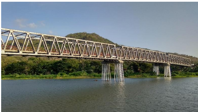
Gambar 5.6. Jembatan Kretek. Sumber Foto: Tim Peneliti 2019
