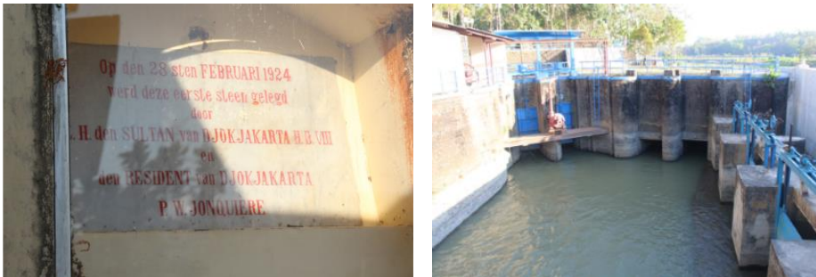
Gambar 2.4. Bendungan Kamijoro yang diresmikan oleh Peresmian Bendungan Kamijoro oleh Hamengku Buwana VIII dan Residen P.W. Jonquier pada tanggal 28 Februari 1924, yang saat ini masih berfungsi dengan baik.
